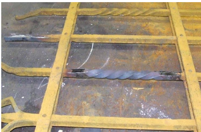
Figuur 17. Ingelast stuk getordeerde spijl.
