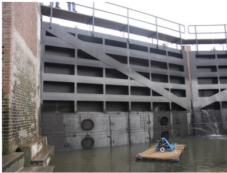
Figuur 22. Sluisdeur, hersteld en verzaamd i.v.m. hogere veiligheidseisen, waarbij oorspronkelijke delen zijn gehandhaafd. Hierdoor kan de sluisdeur een hogere mechanische belasting aan.
