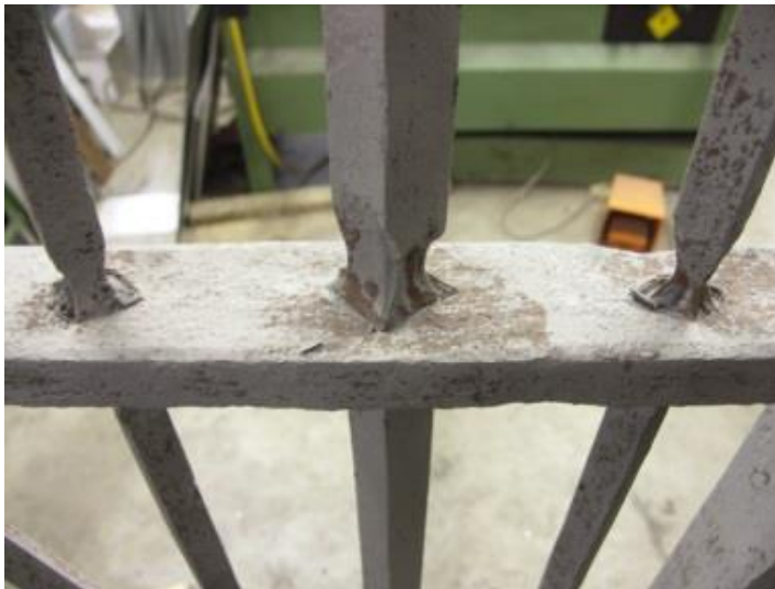
Figuur 5. Aangetaste aangegoten verbinding.
