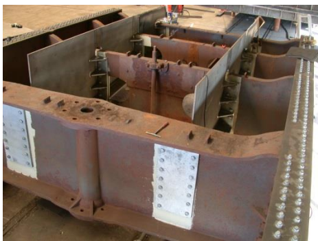
Figuur 23. Brug versterkt i.v.m. zwaarder verkeer, waarbij oorspronkelijke delen zijn gehandhaafd.
